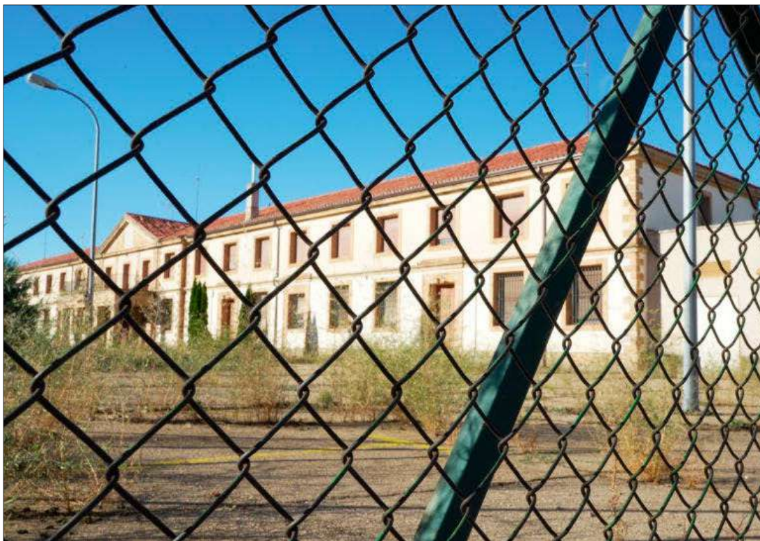
Exterior de la antigua cárcel provincial. HDS
