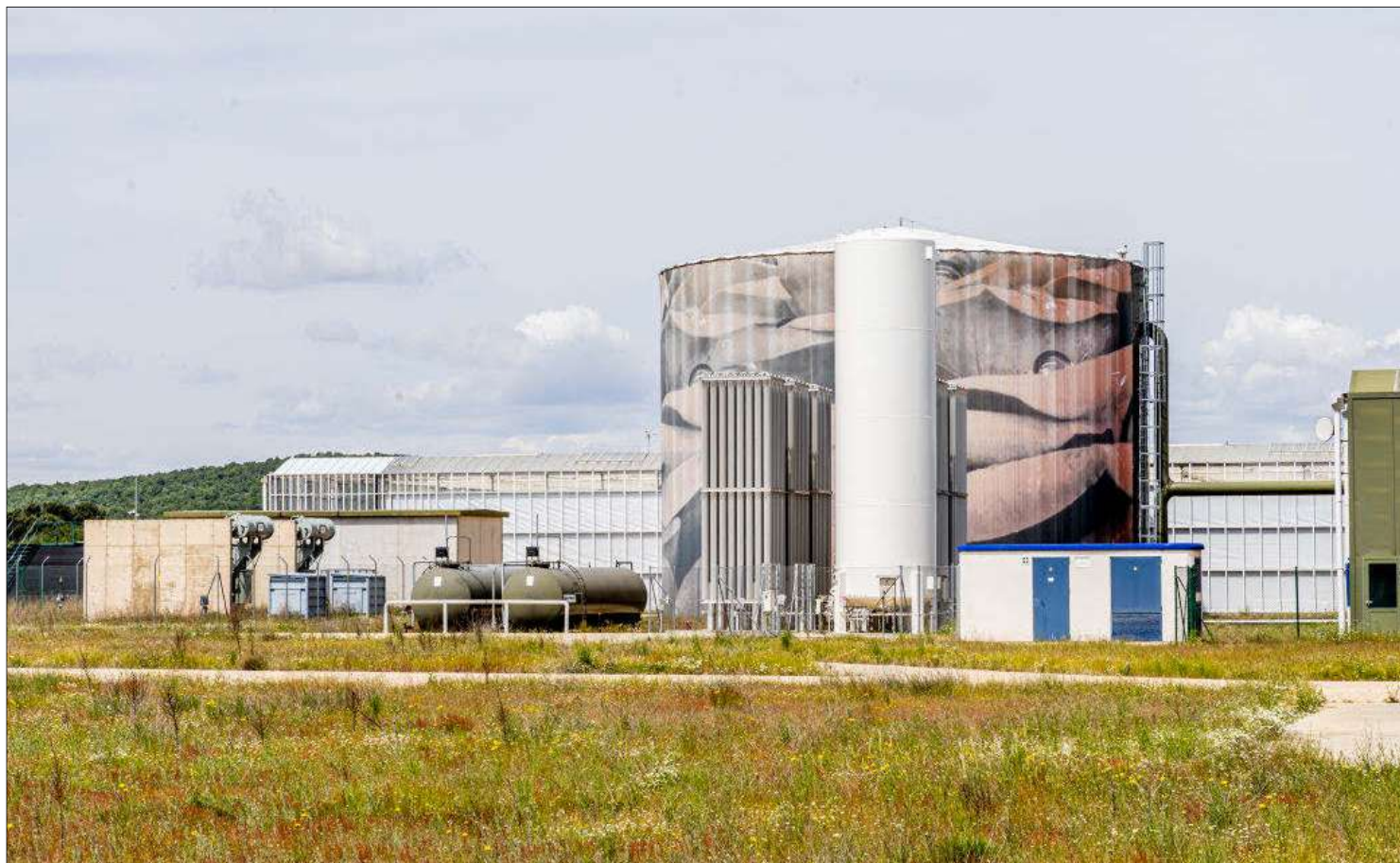
Panorámica de las instalaciones de Ondara en Garra. MARIO TEJEDOR
