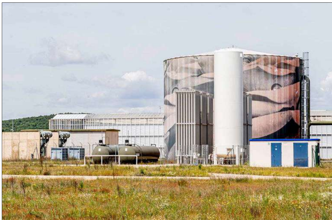
Instalaciones de Ondara en Garray. MARIO TEJEDOR
